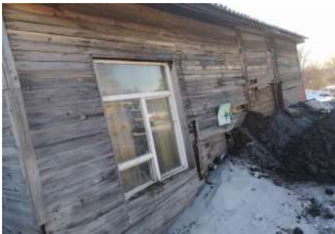
Состояние оконных проемов
