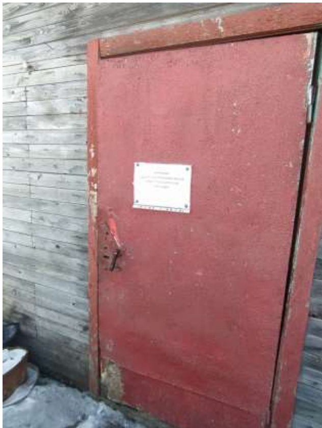
Состояние дверных проемов
