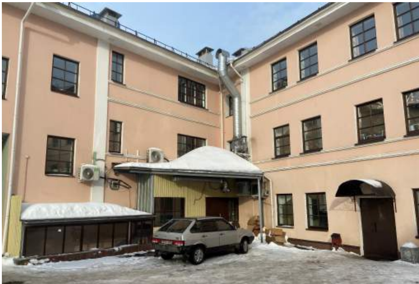
Вид здания со двора
