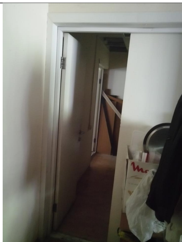
Фото 8. Общий вид нежилого помещения
