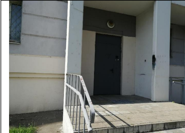
Фото 1. Общий вид отдельного входа в нежилое помещение
