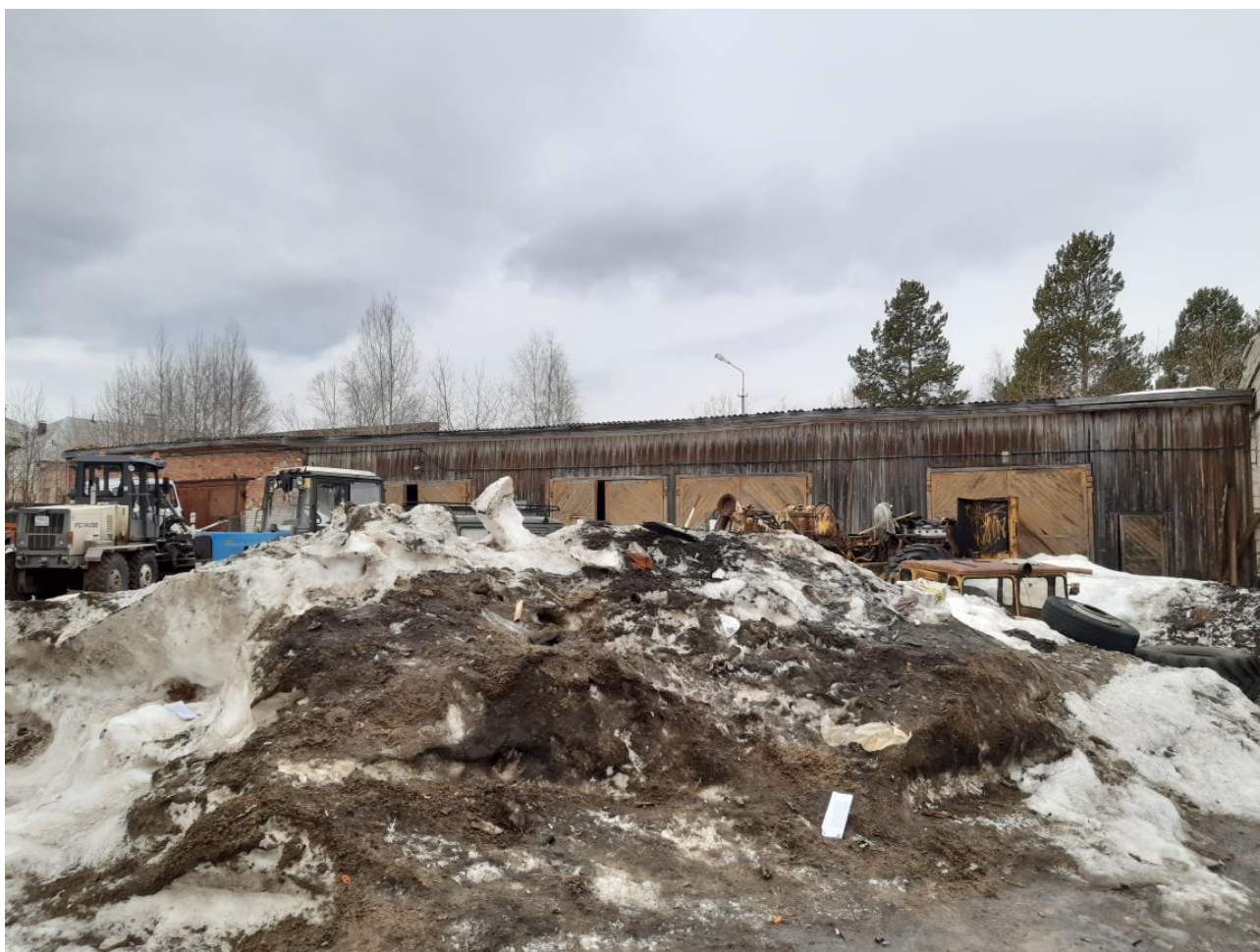
Территория базы МУП «Альтернатива», улица Ленинградская, объект оценки справа на фото.
