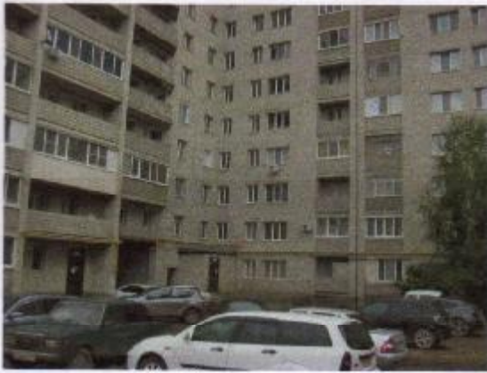
Общий вид жилого дома
