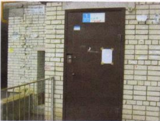
Общий вид жилого дома
