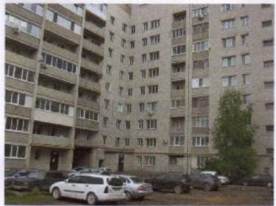
Общий вид жилого дома
