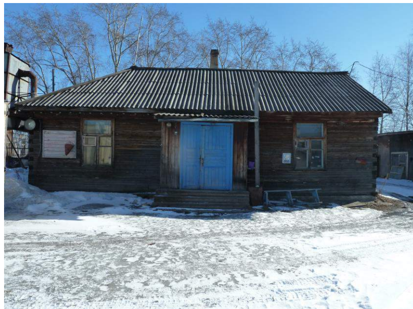
Рис.1 Общий вид здания
